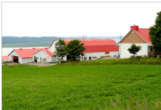
La Ferme Chatel (5452, avenue Royale, Boischatel), photo prise à partir de l'avenue Royale.
