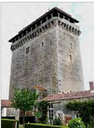
Donjon médiéval de Bazoges-en-Pareds, datant du XIV e siècle, construit sur sept niveaux et couronné de mâchicoulis. Source : http://fr.wikipedia.org/wiki/Bazoges-en-Pareds
