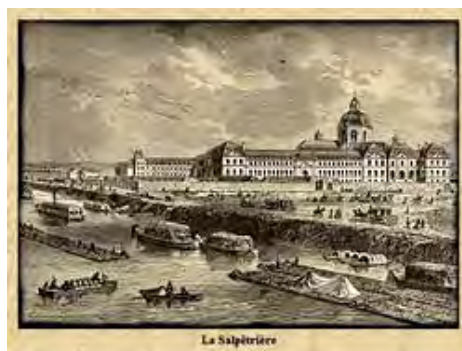
Salpêtrière—vue du fleuve
