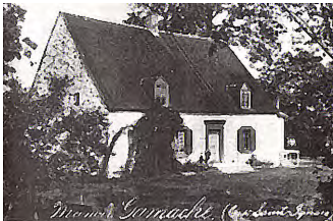
En 1759, la paroisse de Cap-Saint-Ignace n'a plus de véritable église, celle-ci s'étant effondrée dans le fleuve vers 1740. Pendant ces années, c'est notamment le manoir de la famille Gamache qui sert de lieu de culte. Pendant la guerre de la conquête, les Anglais l'auraient donc épargnée conformément aux instructions de Wolfe au sujet des lieux de culte. Ce bâtiment existe encore aujourd'hui.
